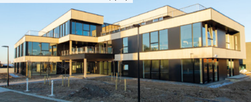
La Pilaterie – Villeneuve-d'Ascq (59)
