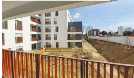
Châtenay-Malabry : Livraison mi juillet 2022 (3 appartements)
